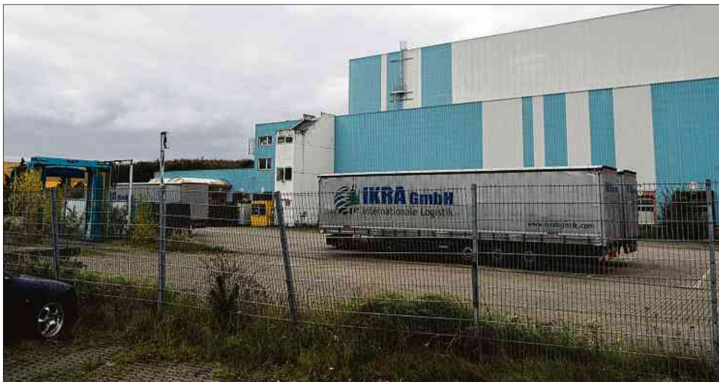
Die Hallen an der Boschstraße 61-65 sollen abgerissen und durch neue Logistikgebäude ersetzt werden. (Foto: Jansen)
