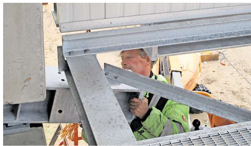
Noch ein bisschen, noch ein bisschen – irgendwann passen die vier großen Bolzenschrauben in den Steg für das noch schwebende Brückenteil.
