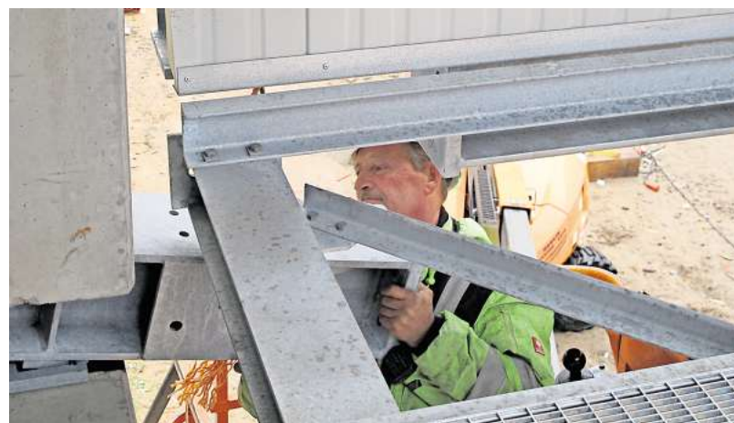
Noch ein bisschen, noch ein bisschen – irgendwann passen die vier großen Bolzenschrauben in den Steg für das noch schwebende Brückenteil.
