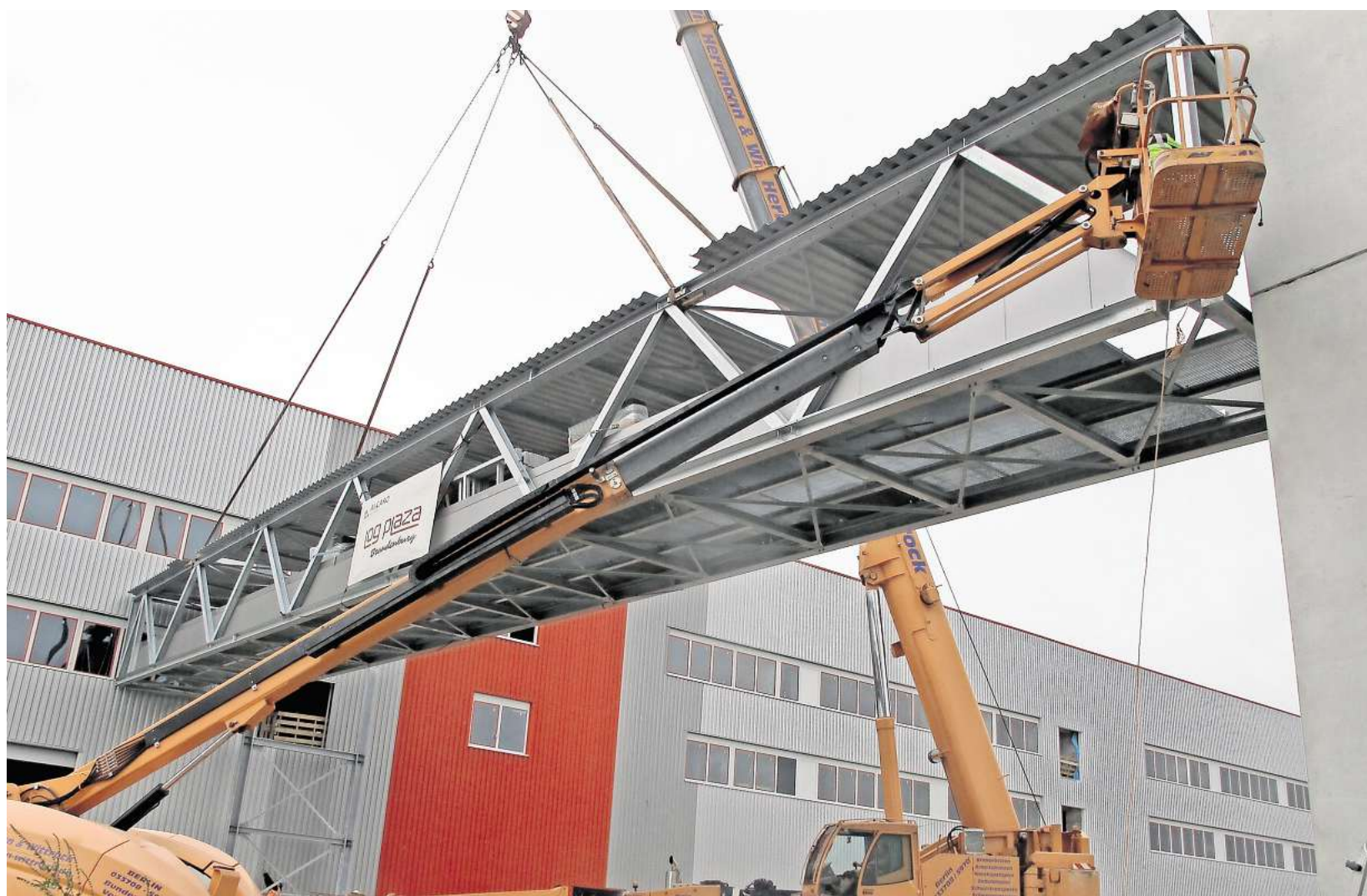
Wind war die größte Herausforderung für die Bauleute, um die 36 Meter lange Brücke bei wenigen Zentimetern Spielraum einzufügen.
